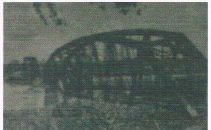
(สะพานข้ามแม่น้ำตาปีตอนถูกระเบิด)
