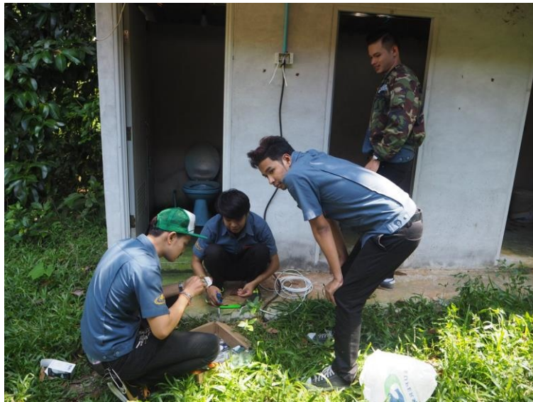
ติดตั้งระบบไฟฟ้าส่องสว่างห้องน้ำ
