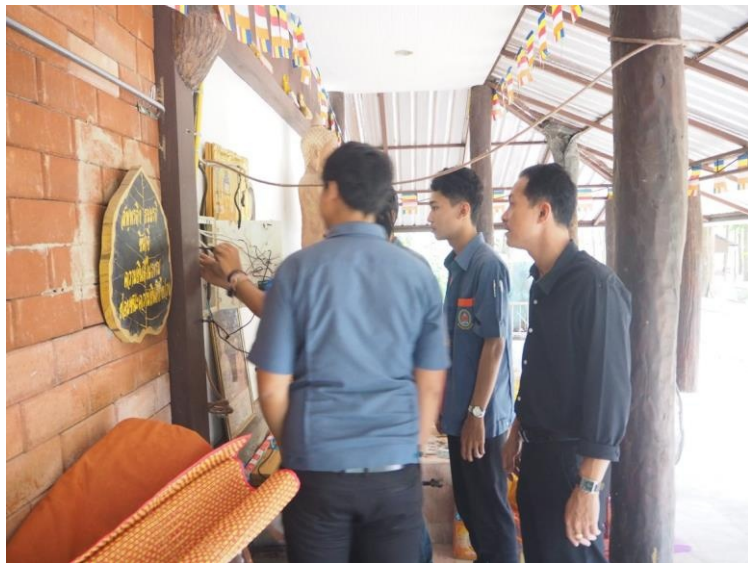
เปลี่ยนแผงควบคุมไฟฟ้า
