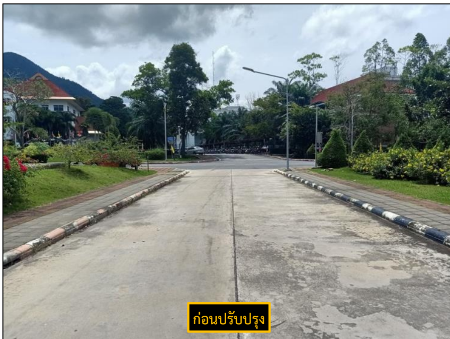
รูปที่ 4 ก่อนติดตั้งอุปกรณ์เตือน
