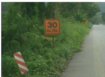
ภาพที่ 4 ป้ายจำกัดความเร็วในเขตก่อสร้างทาง
