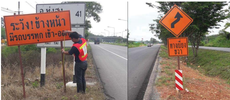
ภาพที่ 6 ป้ายทางเบี่ยง (ภาพซ้าย) และภาพเครื่องหมายควบคุมจราจรในงานก่อสร้าง (ภาพขวา)
