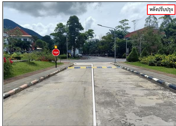
รูปที่ 5 อุปกรณ์จราจร ไฟกระพริบ ป้ายเตือน เส้นหยุด เนินชะลอความเร็ว
