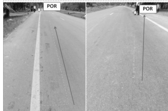
รูปที่ 8 รอยเบรกของรถตู้และรอยกะทะล้อของรถกระบะขีดกับผิวถนน
