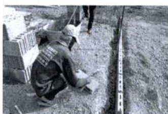
ภาพ 2 ขุดร่อง เทคานและก่ออิฐ
