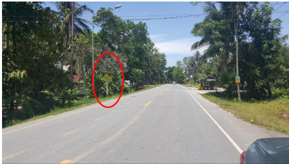
รูปที่ 10 ป้ายทางแยกบริเวณมีสภาพเก่าไม่สะท้อนแสง
