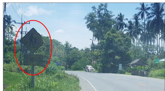
รูปที่ 9 ป้ายเขตโรงเรียน ชำรุดไม่สะท้อนแสง
