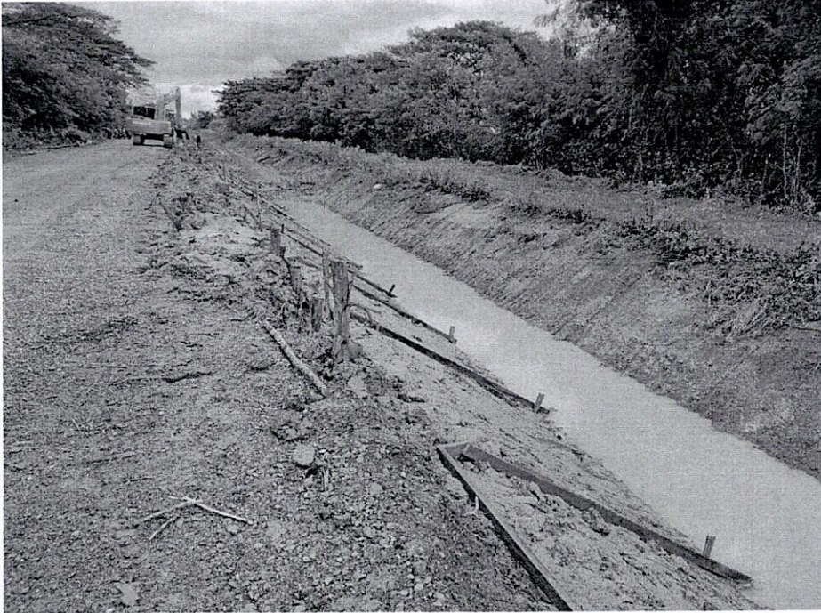
ภาพที่ 3 เก็บรวบรวมข้อมูลภาคสนามด้วยการสังเกตการซ่อมแซมและจัดการระบบชลประทานในช่วงฤดูฝน
